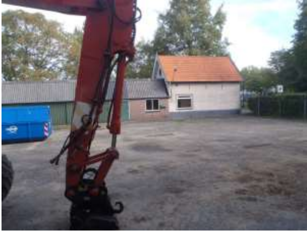
Foto 12: de voormalige sluiswachterswoning met daarachter een lage loods. De loods is aan deze zijde met stalen damwandprofielen bekleed, aan de andere zijde zijn de gemetselde muren met klimop begroeid.
