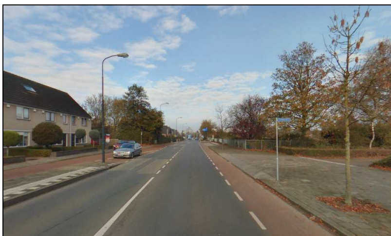
Foto 3.1: Kayersdijk ter hoogte van de Condorweg
