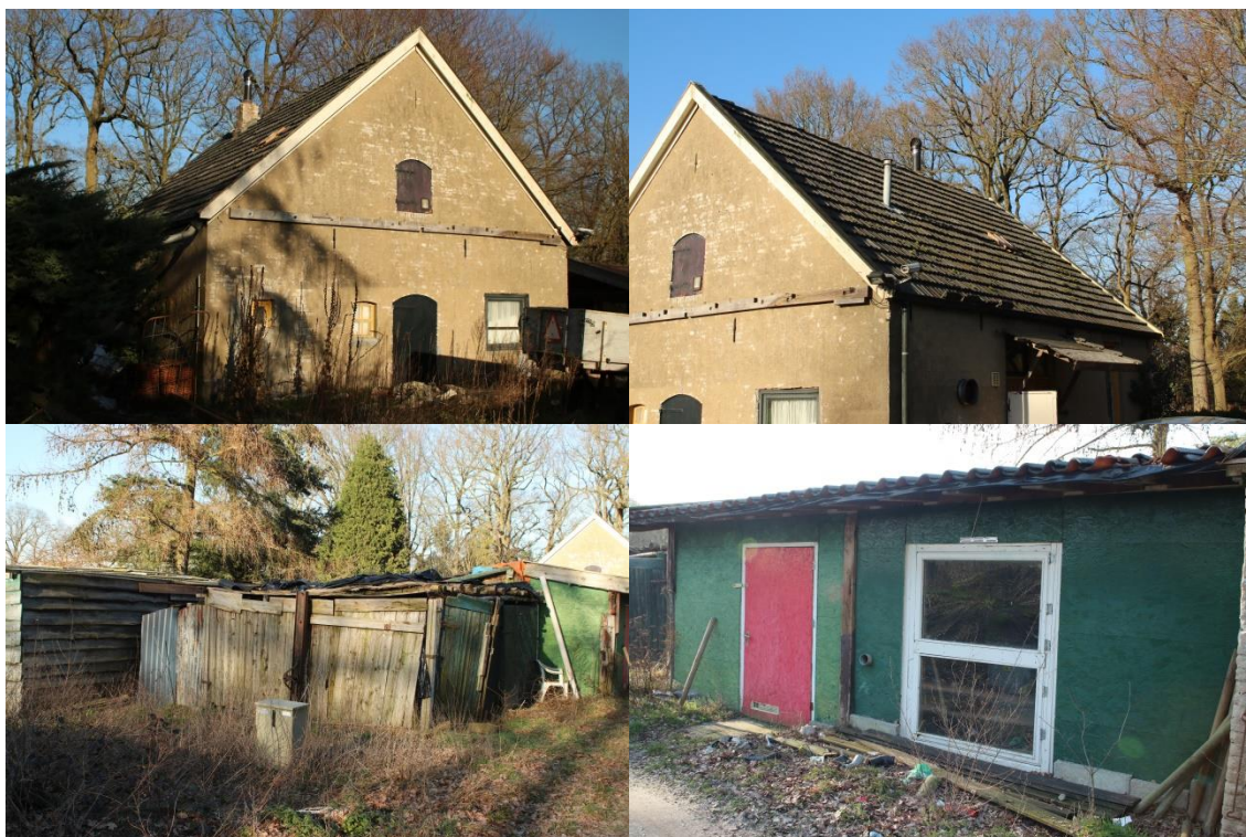
Foto 1-4. Impressie van het plangebied op 24-2-21 met boven de woning en onder schuurtjes in het plangebied.
