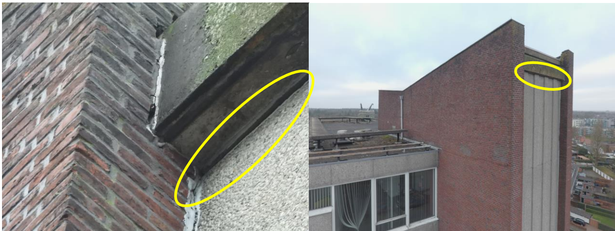
Details van de vermoedelijke winterverblijfplaats van gewone dwergvleermuizen in de lifttoren van het gebouw.
