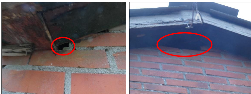
Figuur 4.4. Openingen in muur van grote schuur die vleermuizen toegang kunnen bieden tot de spouwmuur.
