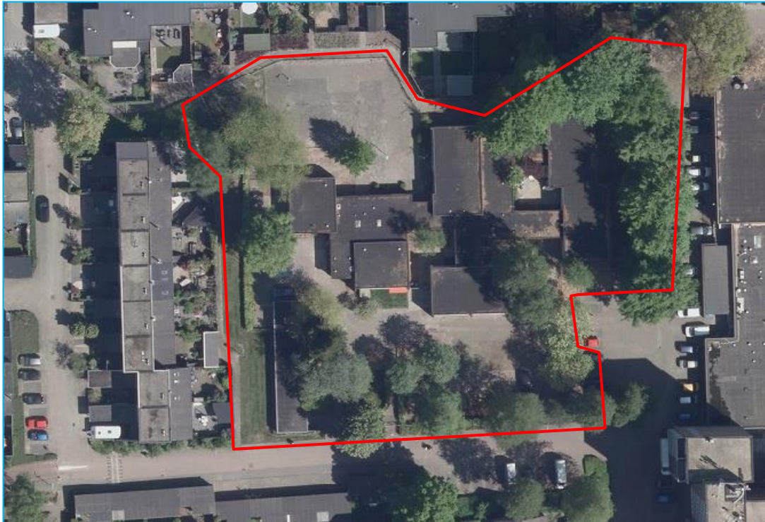
Afbeelding 1: Situering onderzochte gebouwen (bron: Atlas Gelderland, luchtfoto 2017).
