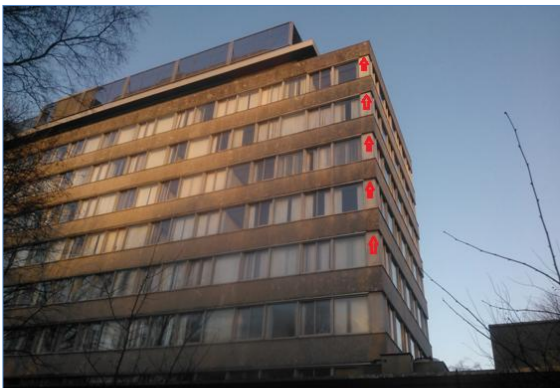
Figuur 3.4: Voor vleermuizen toegankelijke openingen achter gevelbeplating op de hoeken van het te slopen gebouw (rode pijl).
