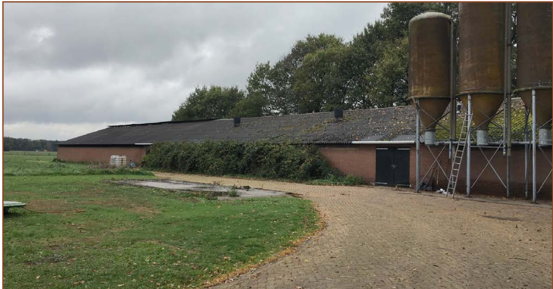
Afb. 2.1: De te slopen stallen op de onderzoekslocatie. De stal beschikt niet over vaste rust- en verblijfplaatsen van vleermuizen en ook nesten van vogels ontbreken. De zijkant van de schuur is begroeid met braam, hier kunnen algemene broedvogels in nestelen, zoals Roodborst of Winterkoning.
