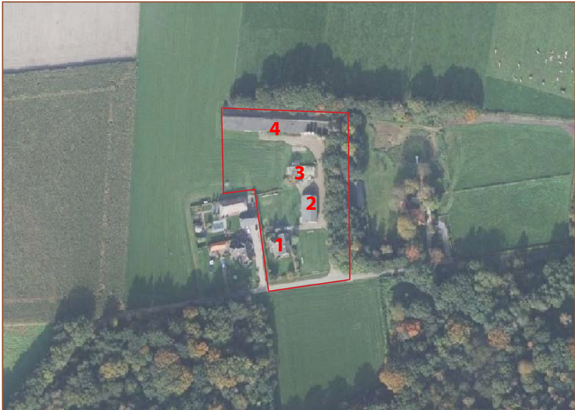
Afb. 1.1: Luchtfoto onderzoekslocatie. Globale begrenzing onderzoekslocatie (rood kader). 1 = bestaande woning, 2 = te slopen schuur, 3 = te slopen schuur/stal, 4 = te slopen stal. Bron ondergrond: PDOK luchtfoto 2017.
