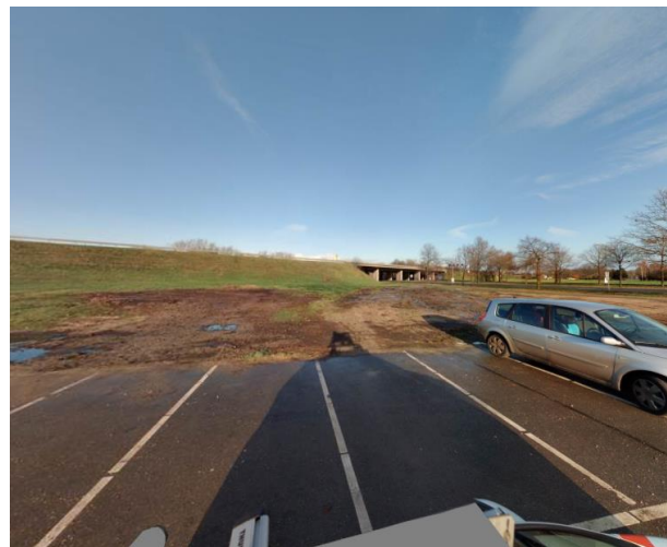
Figuur 3 Zicht op situatie ter plekke locatie verwijsmast
