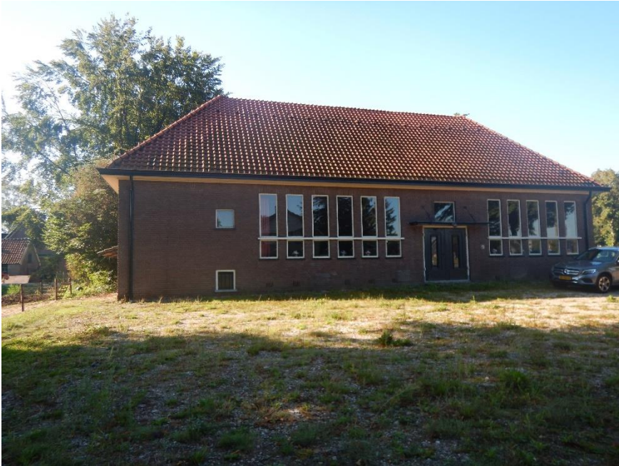
1 Het te slopen gedeelte van het gebouw.
