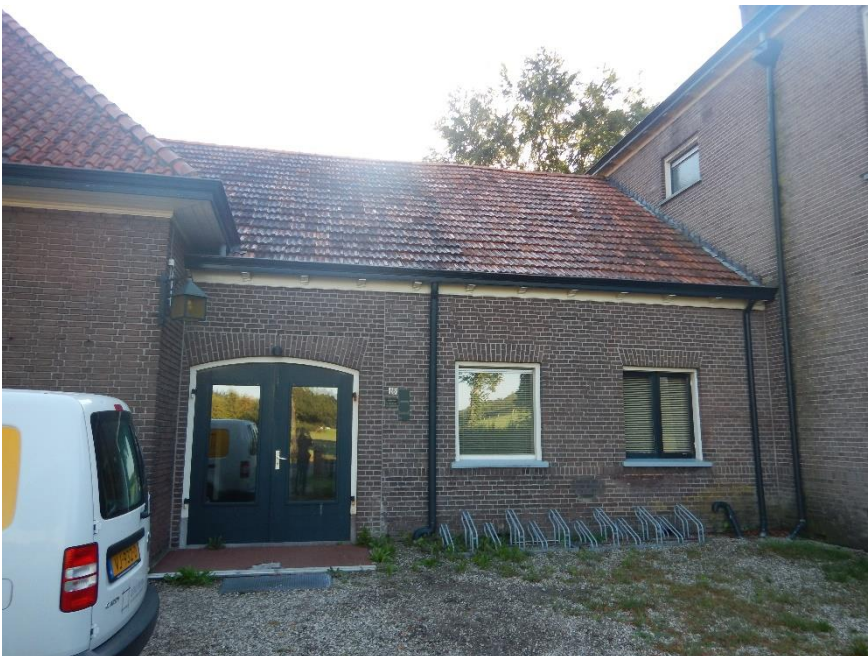
2 De voorzijde van het gebouw.
