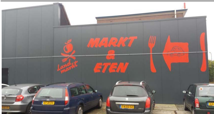
Figuur 3 Gevelaanzicht: ongeschikt voor vleermuizen
