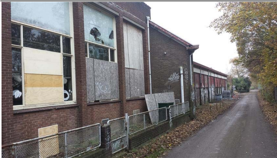
Figuur 4 Foto impressie plangebied (gevel c)
