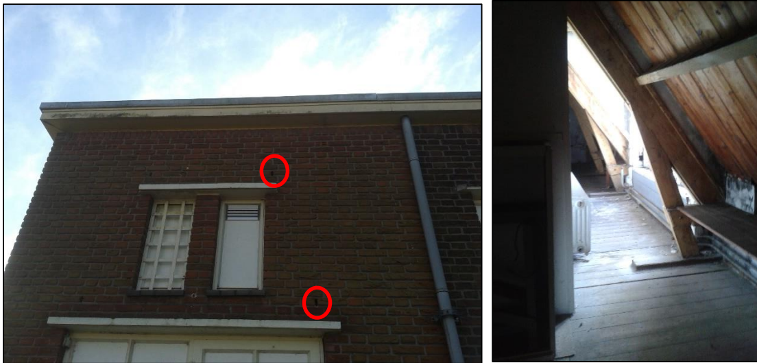
Figuur 3-3. Geschiktheid als verblijfplaats voor vleermuizen (gebouw met open stootvoegen en spouwmuur).
