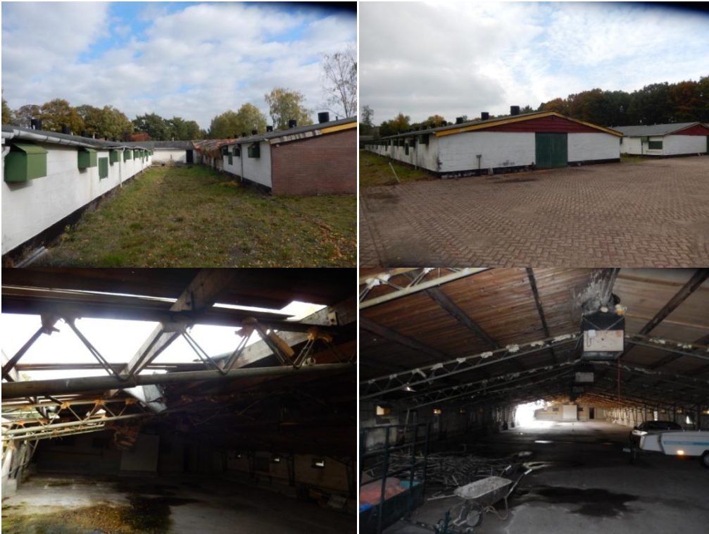
Figuur 1: enkele foto's van de te slopen kippenschuren
