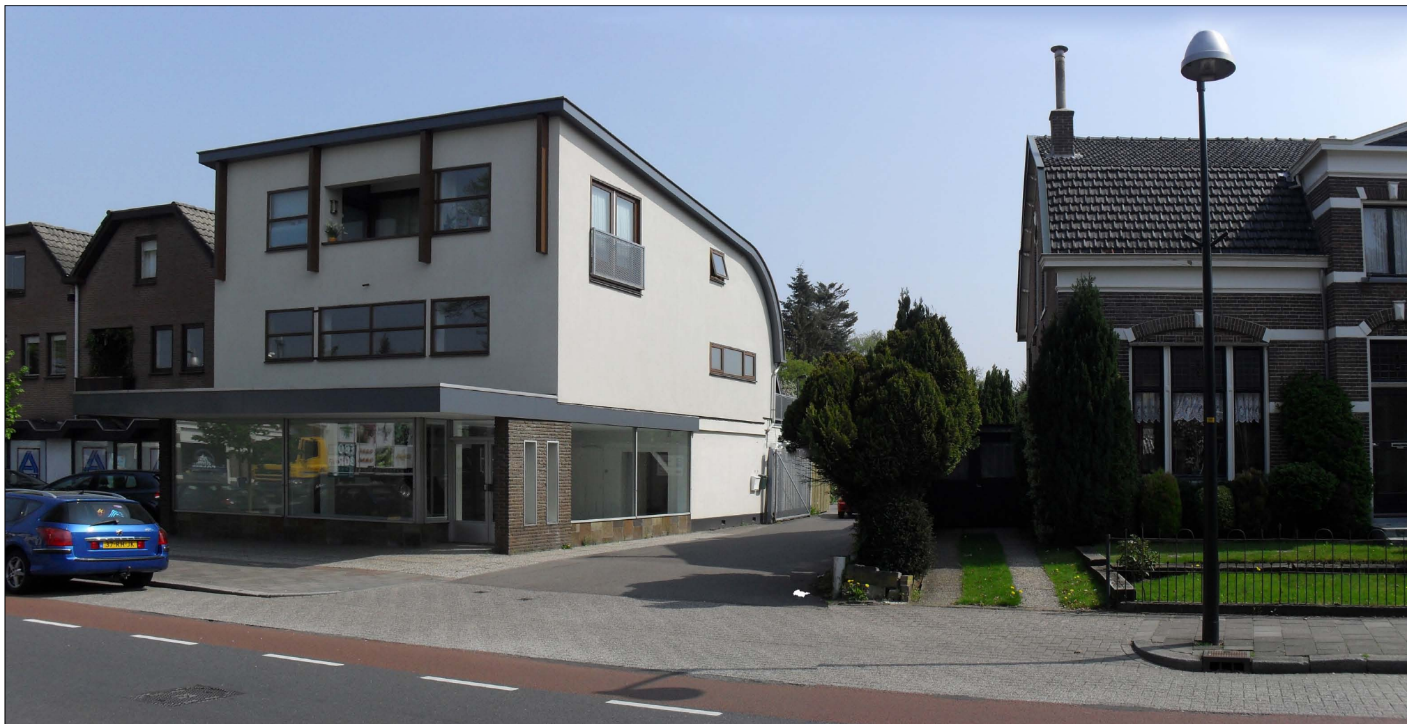
huidige situatie met nieuw schilderwerk en gereinigde gevels
