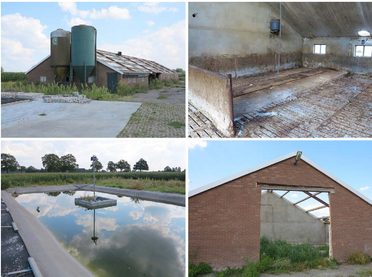
Impressies van het huidige erf met oude veestal, binnenruimte, waterbasin en gebouw na dakverwijdering.
